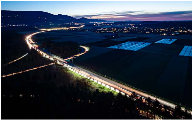
L’ASTRA Bridge sur l’autoroute A1 permettant de maintenir le trafic routier pendant l’exécution des travaux au-dessous du pont. Pour garantir le passage des véhicules sans restriction de vitesse, la rupture de pente a été optimisée par le rallongement et la réduction de la déclivité des rampes d’accès et de sortie.
